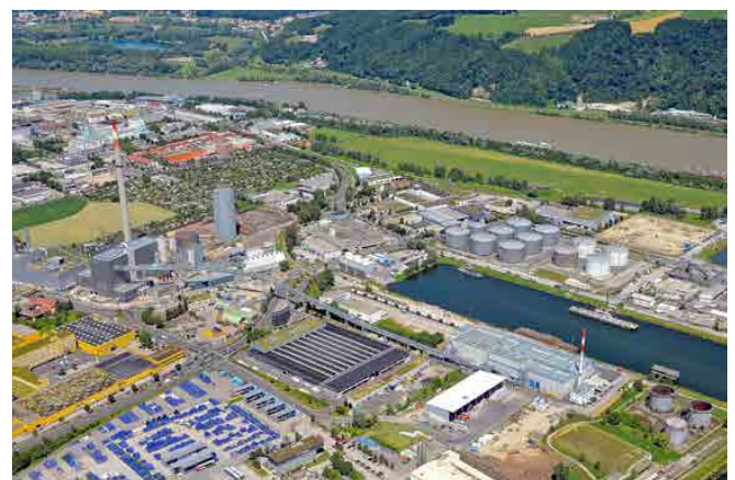
Das Reststoffheizkraftwerk der LINZ AG liefert Energie aus heizwertreichen Reststoffen und Klärschlamm.
